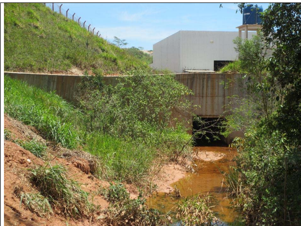
Foto 6.2.5.5-1: Porção inicial do trecho. Saída da galeria subterrânea, a falta de vegetação na margem do rio contribui para o desenvolvimento de processos erosivos com consequente carreamento de sedimentos para o leito do rio.
