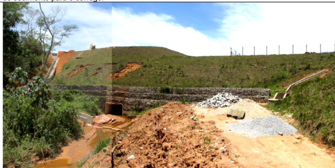
Foto 6.2.5.5-3: Final do trecho 1, na entrada para a galeria subterrânea. Notar material depositado na margem direita do córrego e sedimento no leito do rio. Destaca-se os 2 dispositivos hidráulicos localizadas ao lado da galeria.
