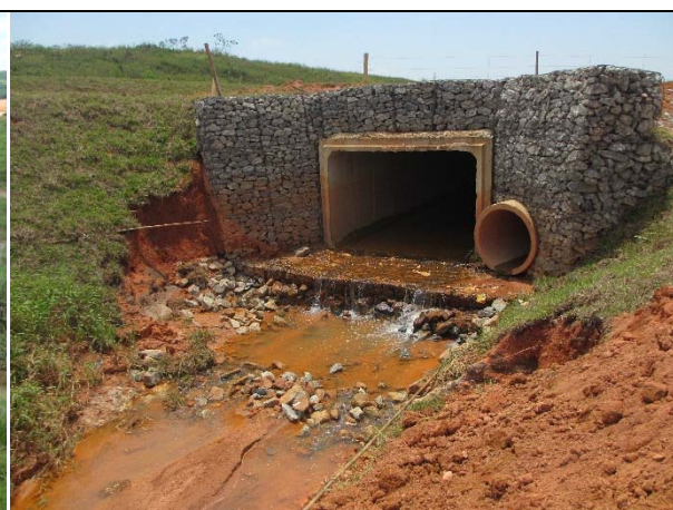
FOTO 6.2.5.5-5: Galeria de travessia, com erosão nas margens do córrego.
